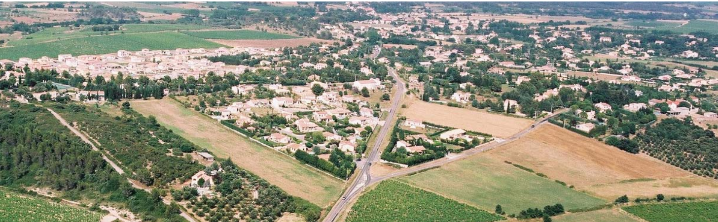
Agglomération de Montpellier - Saint Drézéry
